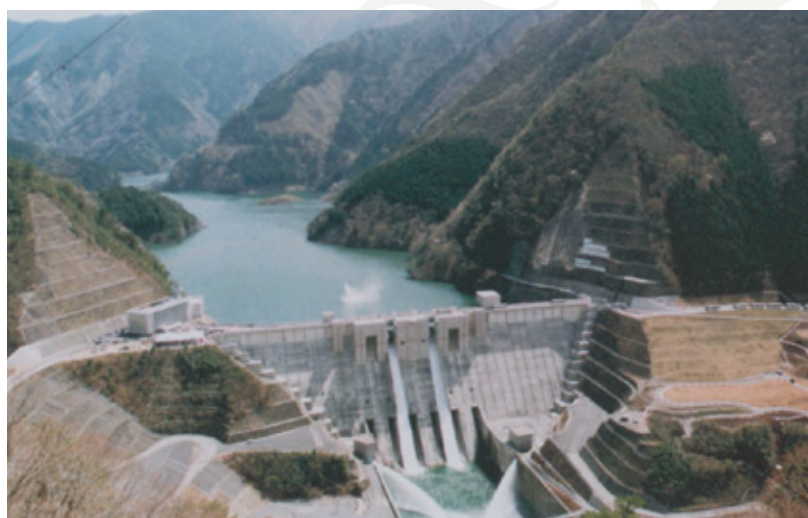
長島ダムが完成
