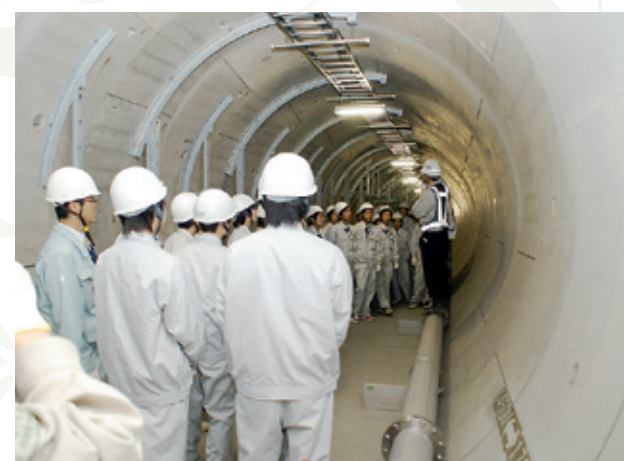
島田工業高校生現場視察研修会(国道1号静岡共同溝静岡西地区)
