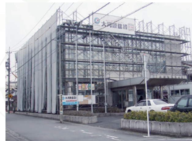
建設業会館 大改修
