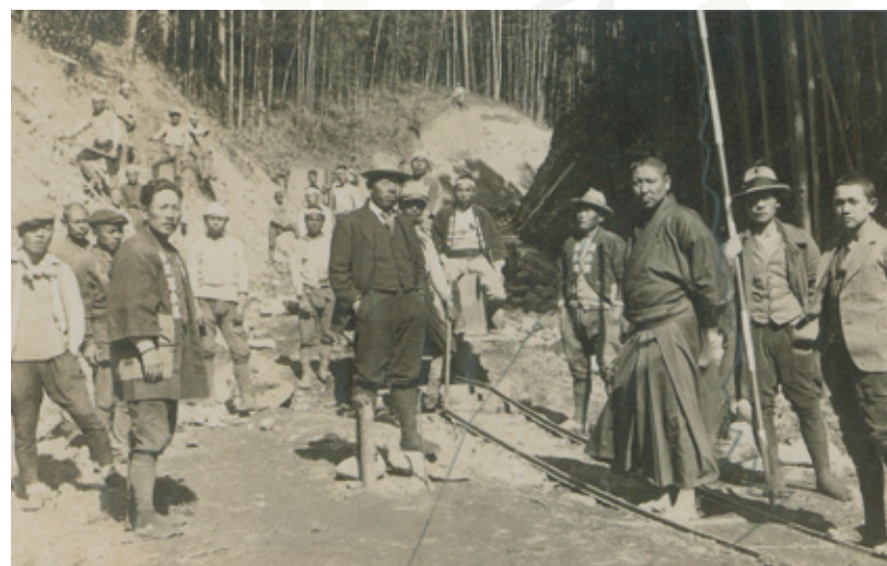
その当時の工事風景
