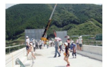
親子現場見学会(太田川ダム建設現場)
