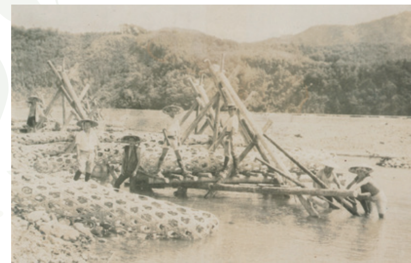
その当時の工事風景
