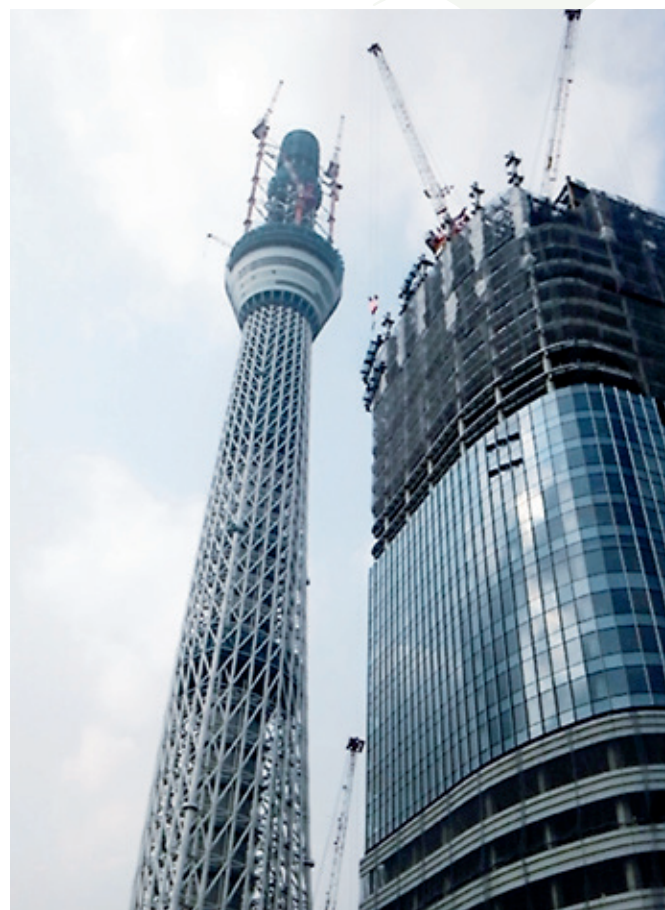
東京スカイツリー現場視察
