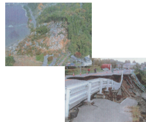
新潟中越地震被害状況
