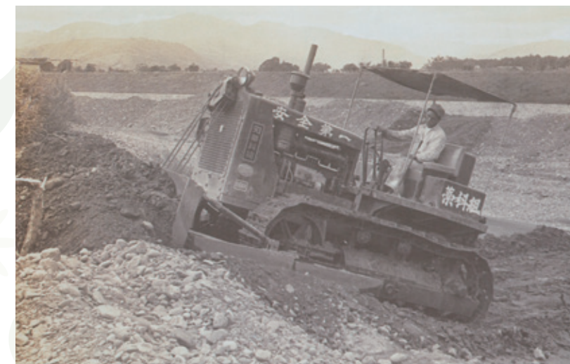
その当時の工事風景
