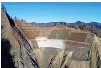
山腹工（榛原川地区 ホーキ雑）
