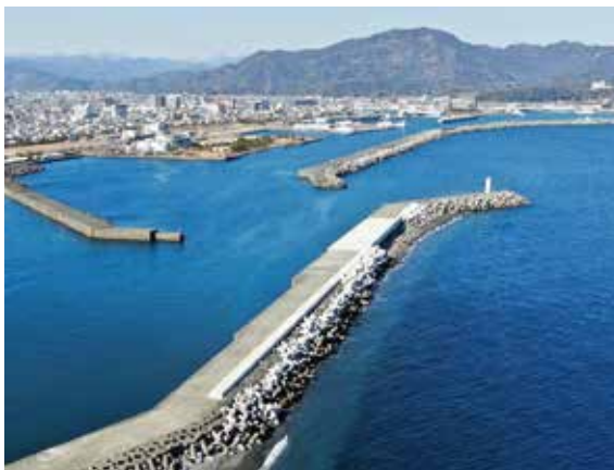
小川南防波堤の改良
