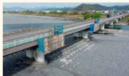
吊足場設置完了
