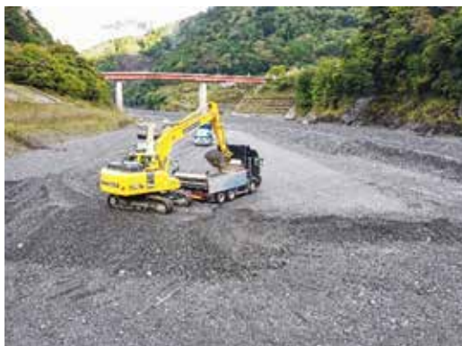
堆砂掘削状況（ダム上流部）
