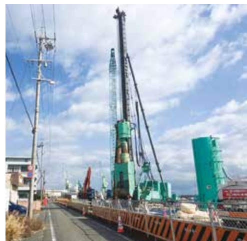
津波対策施設の整備（杭打ち工）
