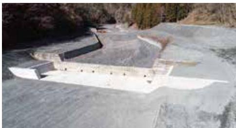
溪間工（大井川地区 東河内）
