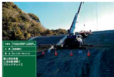
ブロックマット据付作業状況
