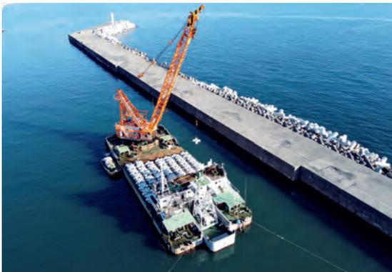
防波堤の粘り強い構造への改良
