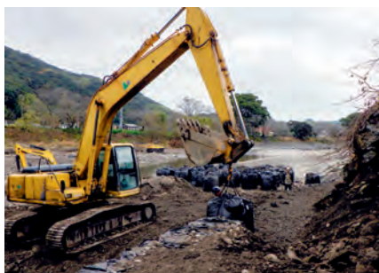
藤枝市内 瀬戸川助宗橋付近応急工事
