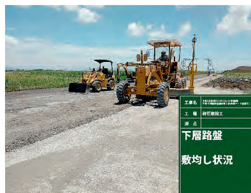
下層路盤敷均し状況（ICT施工）
