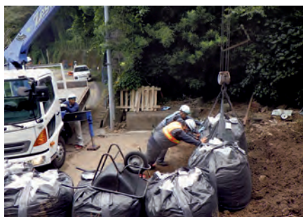
(一) 静岡焼津線の大型土嚢設置
