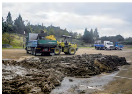
藤枝総合運動公園管理事務所前駐車場土砂撤去工事
