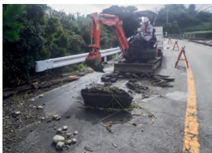
(国) 473号線牧之原市東萩間での流出土砂等を撤去
