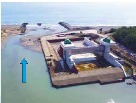
二級河川坂口谷川 水門 (令和3年2月撮影)
