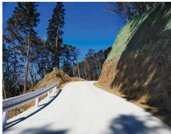
開通した「林業専用道京柱線」 (島田市川根町身成)
