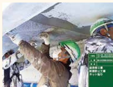
作業中 庇改修
