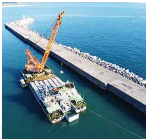
防波堤の粘り強い構造への改良
