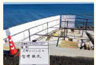
上部コンクリート型枠設置状況
