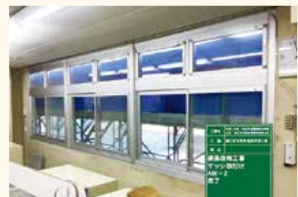
完成 建具改修
