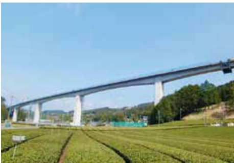
国道473号 金谷相良道路Ⅱ 菊川の里大橋 (令和3年4月撮影)
