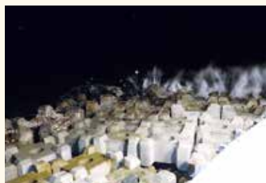
被覆ブロック設置状況
