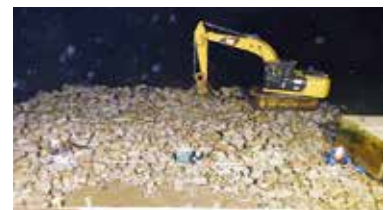
基礎捨石 本均し完了
