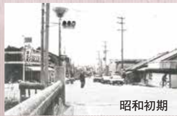
勝草橋より志太を望む
