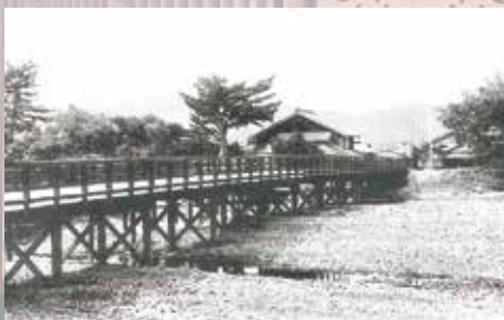
志太側から見た勝草橋 （大正時代）
