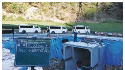
ボックスカルバート設置
