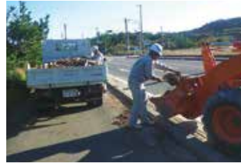
道路のゴミや流木を撤去
