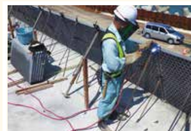
残存型枠組立
