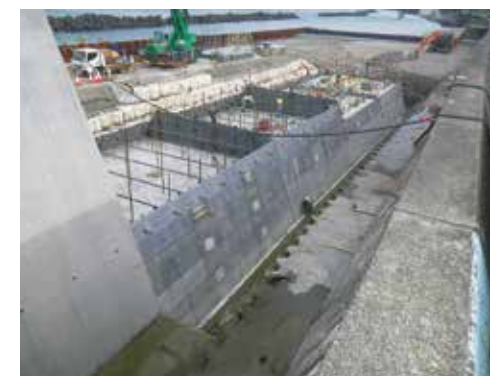
残存型枠組立
