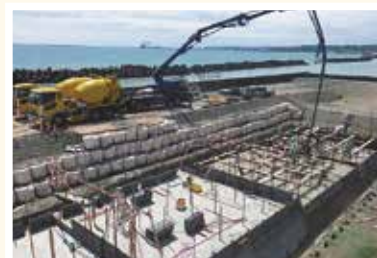
コンクリート打設
