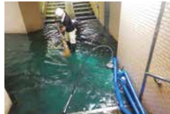
地下道から排水ポンプで水を汲み上げ
