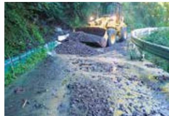
道路の土砂を撤去
