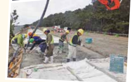
コンクリート打設
